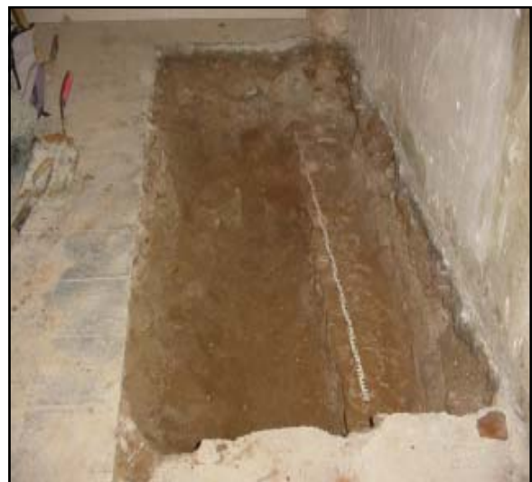
Cala 2 i vista del fonament u.e.30
