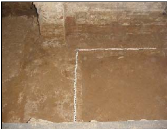
Vista de la riostra u.e. 07 i del fonament u.e.08
