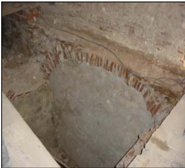
Detall del procés de desmuntatge de la u.e. 24
