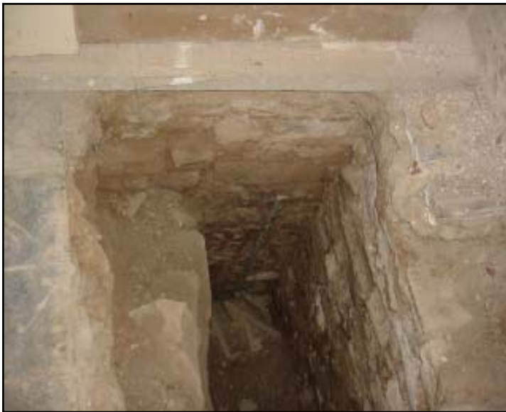
Detall de la cala 3 i el fonament de l'edifici
